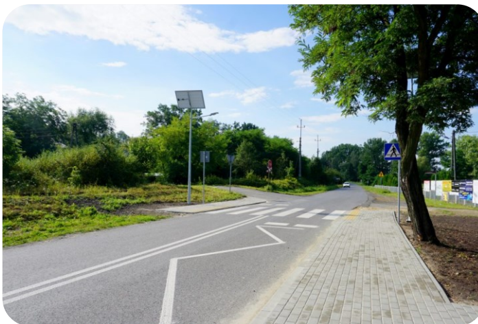
Jazowa zakończenie Widok na jezdnię, chodnik, przejście dla pieszych i dwie lampy solarne doświetlające przedmiotowe przejście
