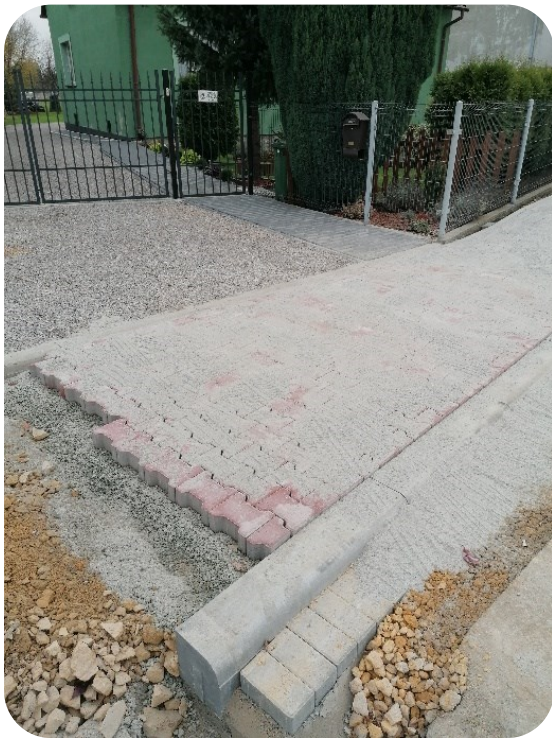
Grunwaldzka realizacja Widok na częściowo ułożoną czerwoną kostkę brukową na zjeździe do posesji, krawężnik betonowy i ściek przy krawężnikowy
