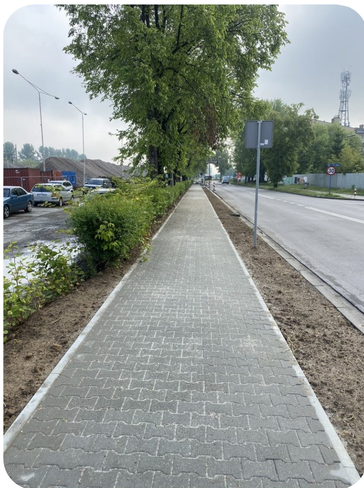
Chodnik przy ul. Powstańców Śląskich po remoncie
