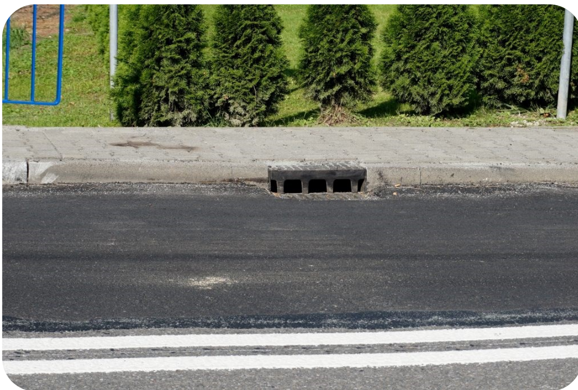
Jędrzejowskiego zakończenie Widok na jezdnię, białe oznakowanie poziome drogi, wpust krawężnikowy i chodnik
