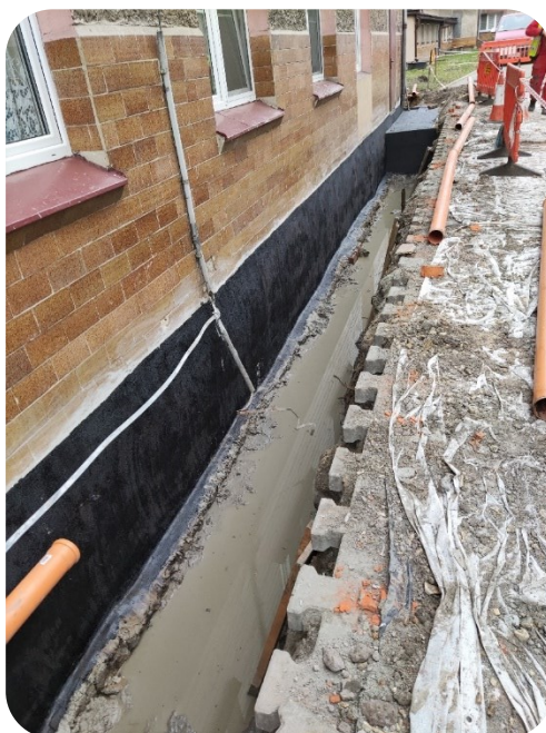
Izolacja fundamentu budynku „A” Domu Pomocy Społecznej w Bobrku
