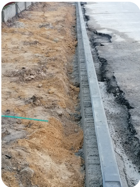
Kongresowa realizacja. Widok na wbudowany krawężnik, wykonaną ławę pod krawężnik i na podbudowę pod nowy chodnik
