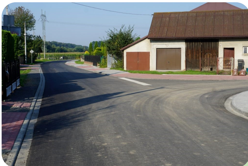
Widok skrzyżowania po remoncie
