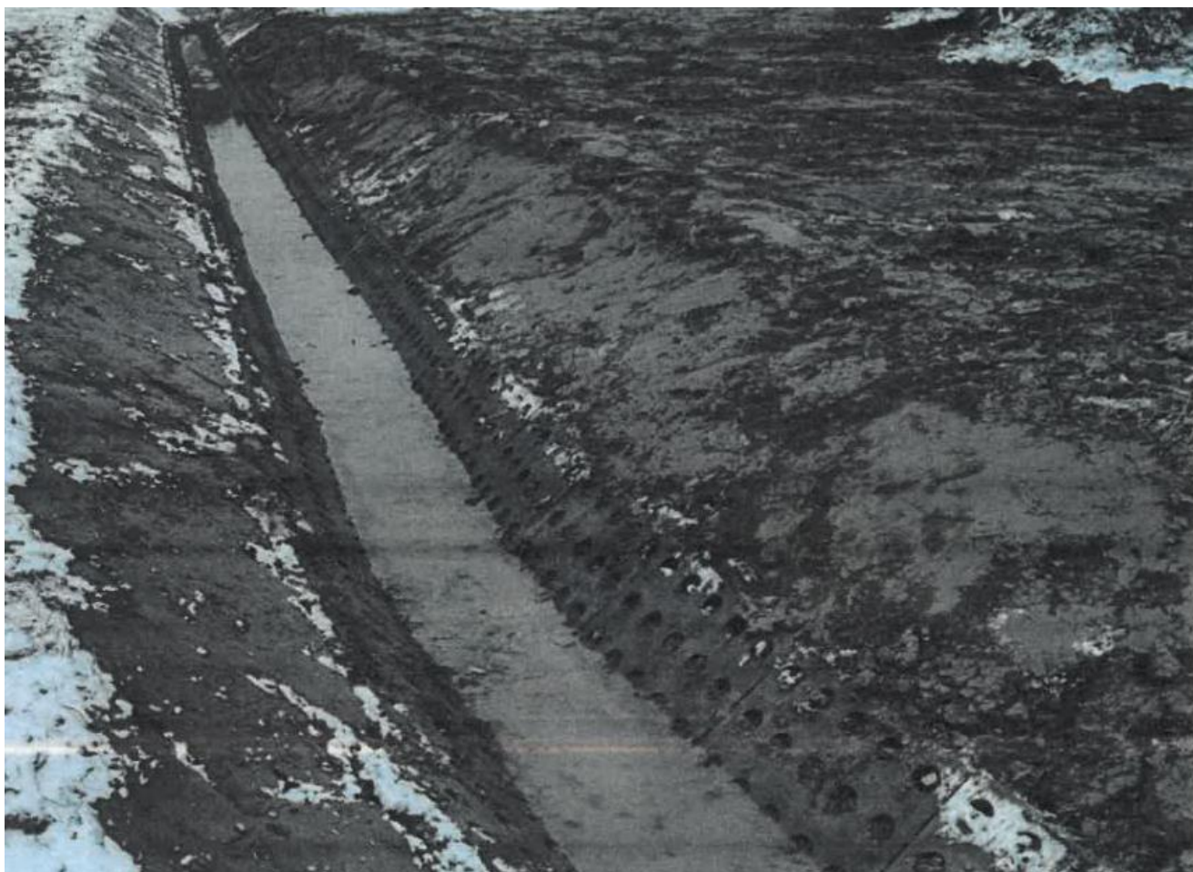
Zdj. Modernizacja rowów w Monowicach i Bulowicach - Miejska Spółka Wodna w Oświęcimiu
