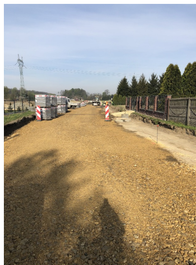
Widok remontowanej drogi
