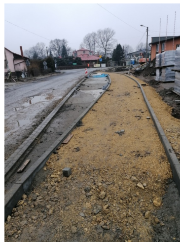
Widok remontowanej jezdni i chodnika.
