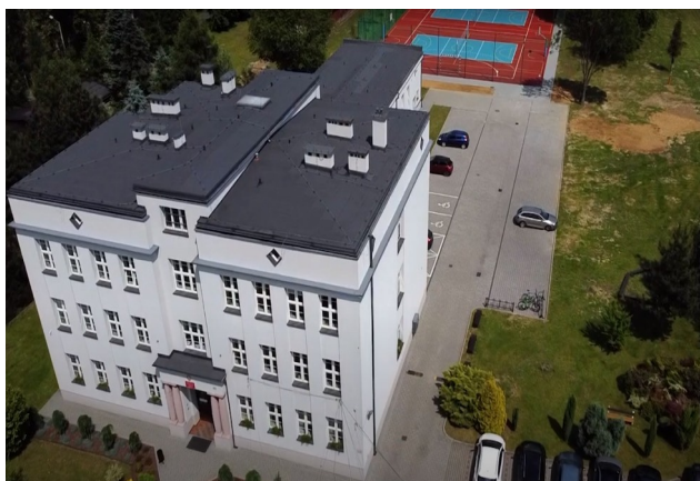
Budynek szkoły z lotu ptaka
