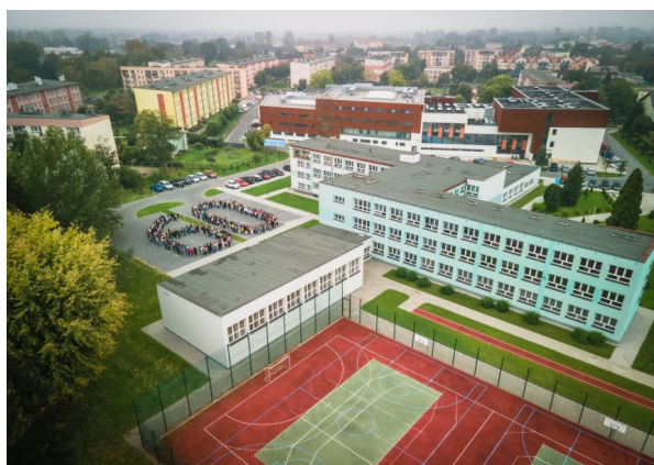
Budynek szkoły z lotu ptaka
