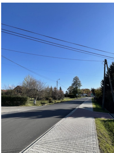
Widok nowej jezdni i chodnika
