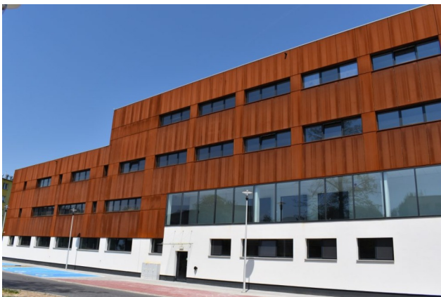
Widok elewacji budynku
