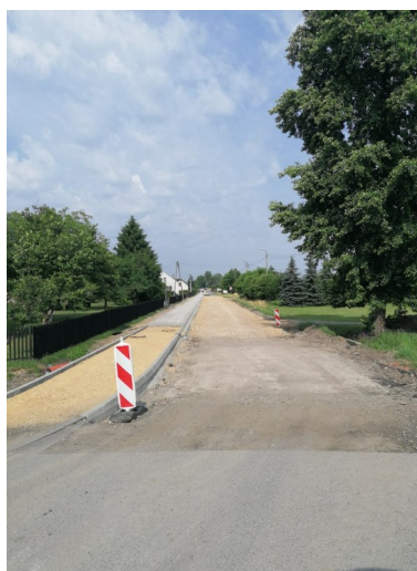
Widok remontowanej jezdni i chodnika
