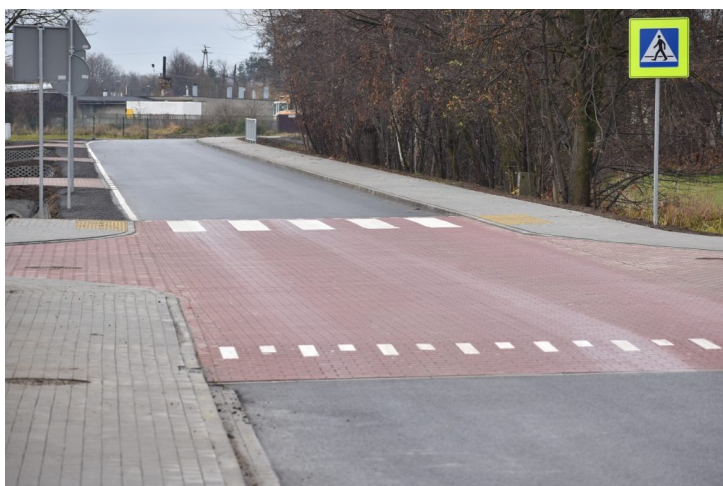
Widok jezdni, chodnika, oznakowania oraz przejścia dla pieszych.
