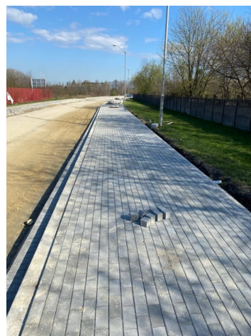
Widok remontowanej jezdni i chodnika
