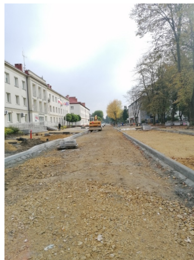
Widok remontowanej jezdni, chodnika i miejsc parkingowych
