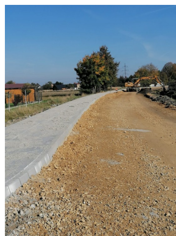
Widok remontowanej jezdni, w tle widoczne prace budowlane.
