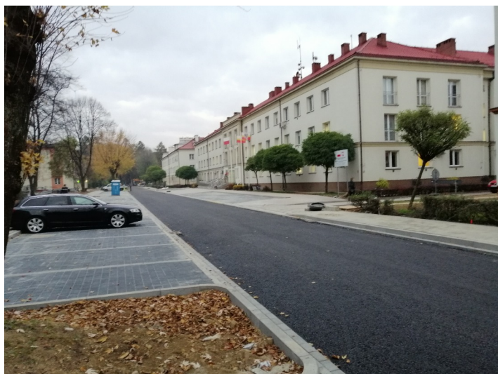
Widok nowej jezdni, chodnika i miejsc parkingowych, w tle Starostwo Powiatowe
