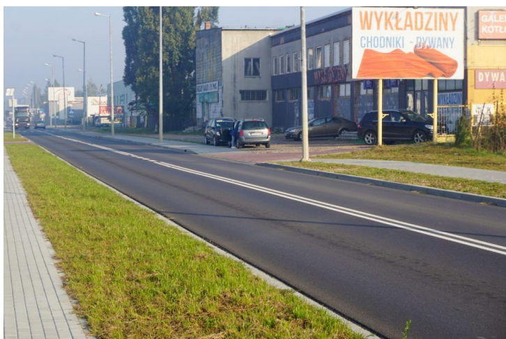
Widok nowej jezdni, w tle sklep, samochody
