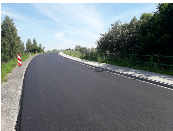
Widok nowej drogi i chodnika
