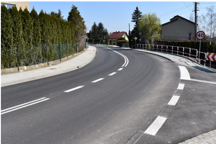
Widok nowej jezdni i chodnika
