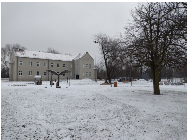
Budynek Muzeum po zakończeniu inwestycji
