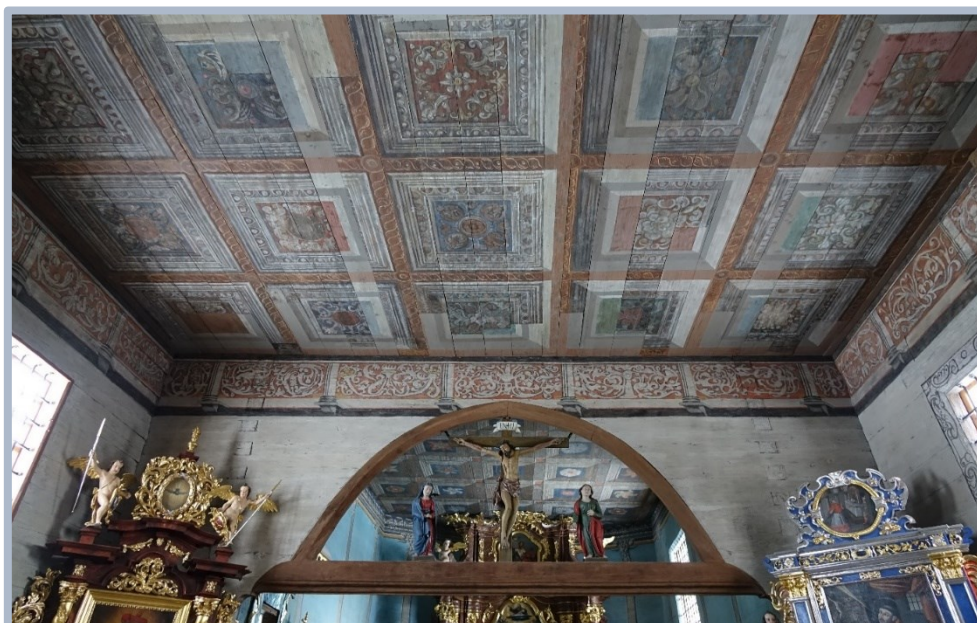
Kościół pw. Św. Andrzeja Apostoła w Osieku
