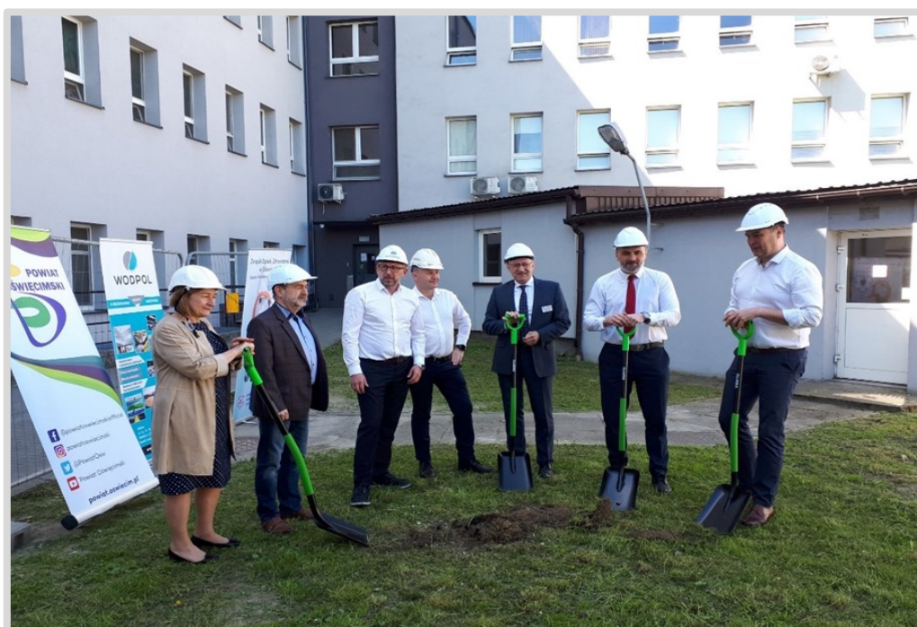
Członkowie Zarządu Powiatu i dyrektor ZOZ - symboliczne „wbicie łopat” pod budowę Centrum Diagnostycznego
