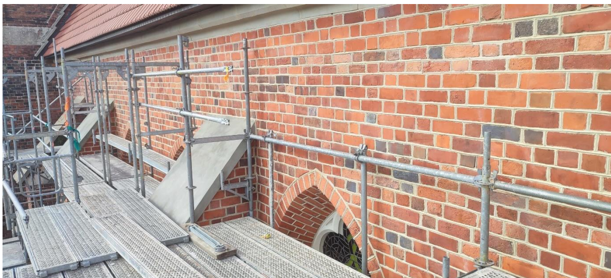
Prace konserwacyjne elewacji zewnętrznych - elewacja południowa Sanktuarium MBWW
