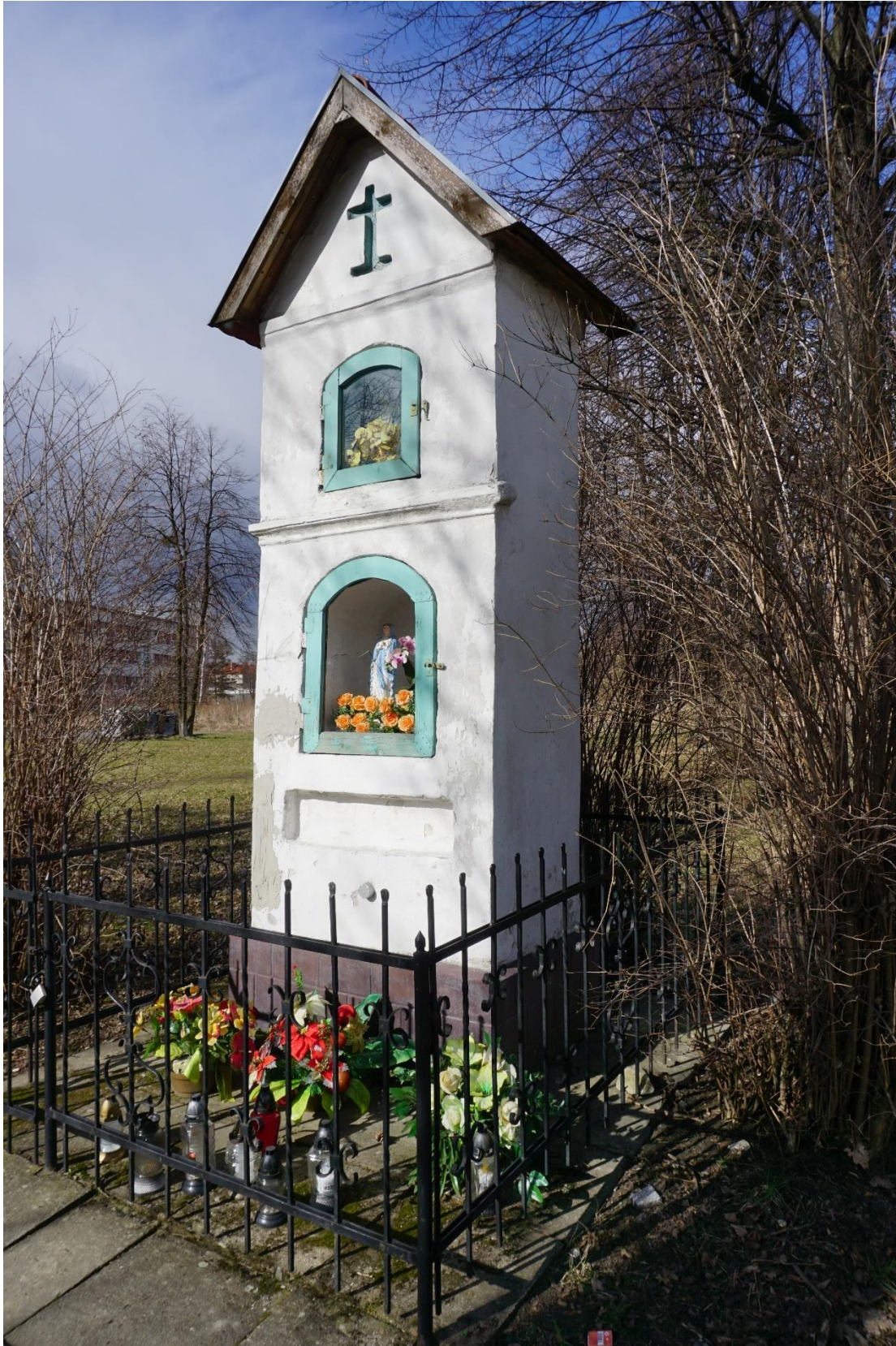
Kapliczka przed remontem
