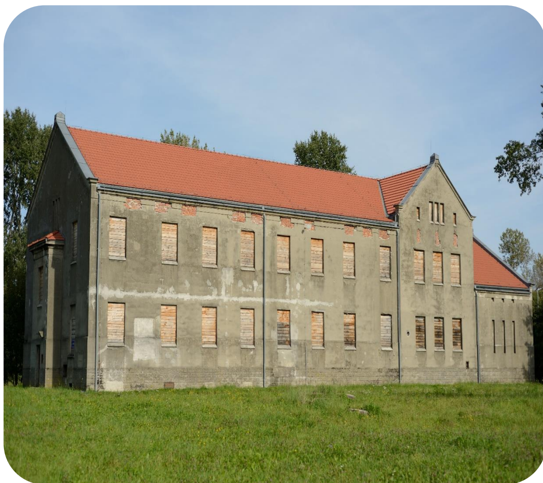
Budynek Lagerhaus - stan obecny
