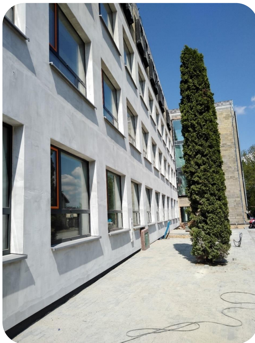
I etap budowy SOSW
