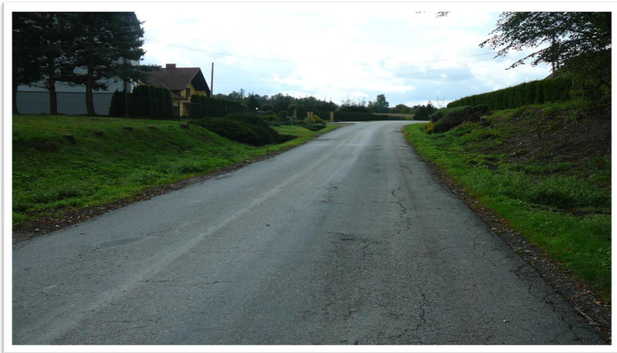
Widok drogi przed przebudową (ul. Karpacka, Witkowice)
