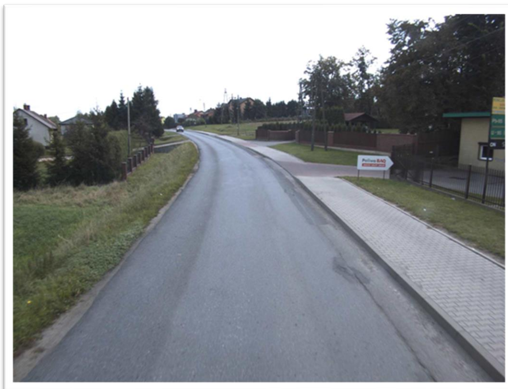
Droga przed remontem (ul. Główna, Osiek)
