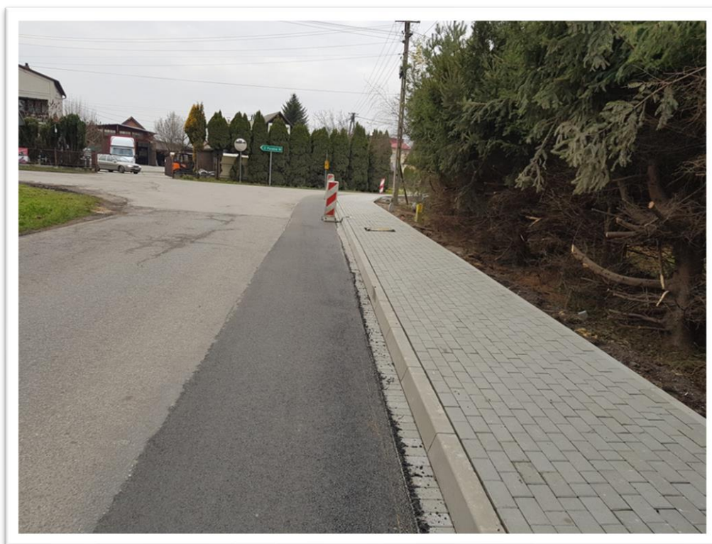
Chodnik wzdłuż ul. Suskiego we Włosienicy
