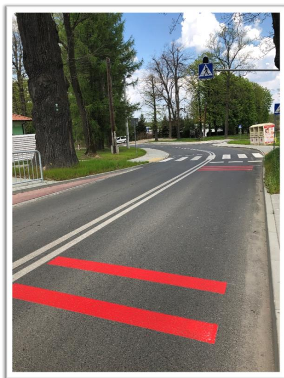
Droga po remoncie
