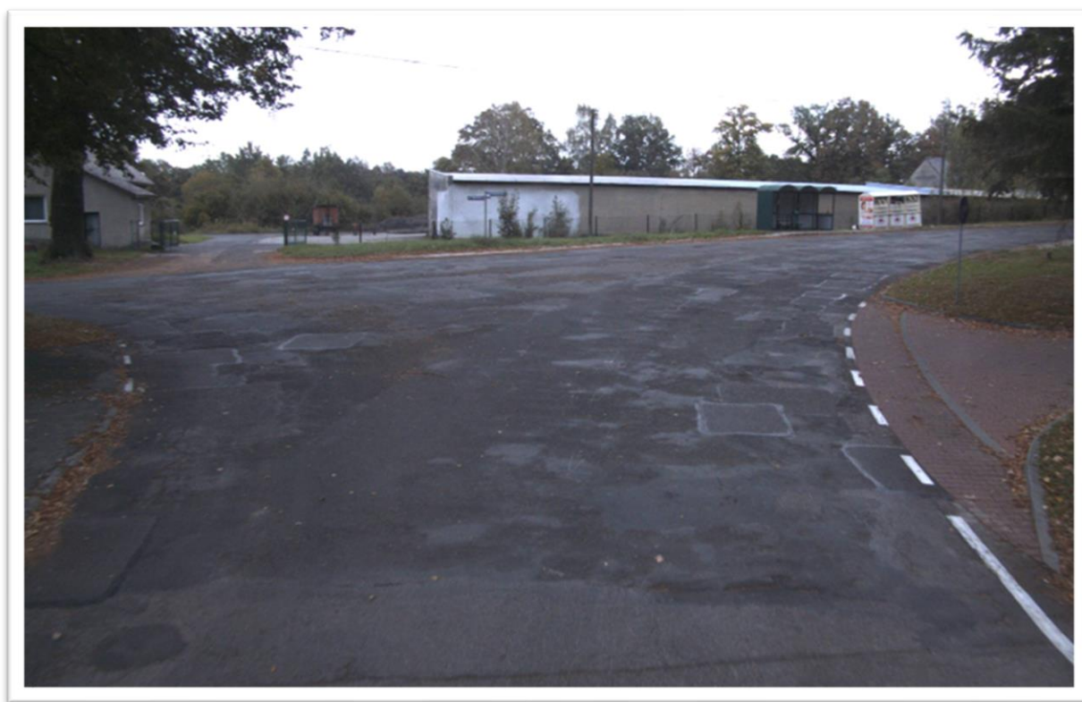
Droga przed remontem (skrzyżowanie ulic Świętojańskiej, Stawowej i Podbeskidzkiej w Malcu)
