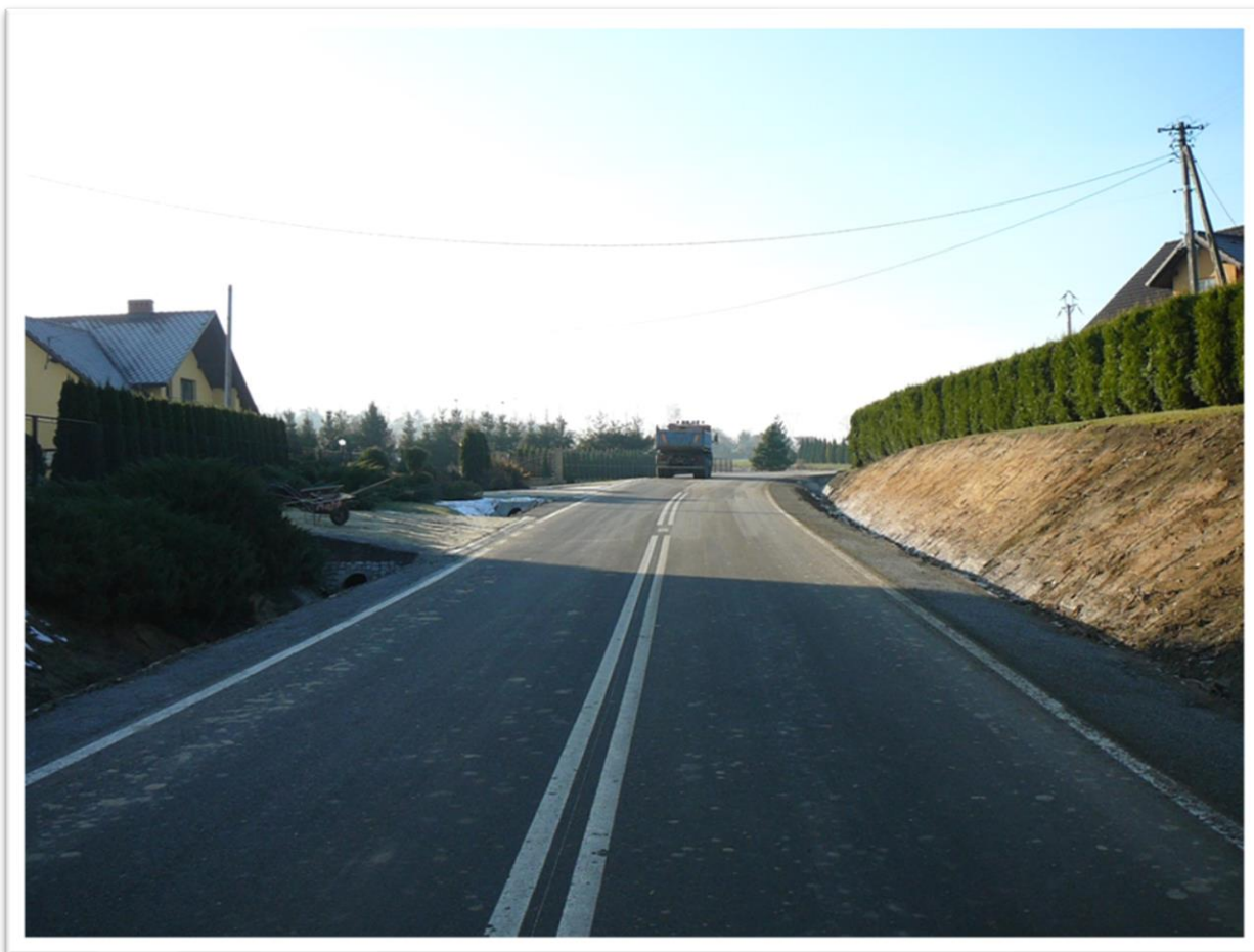
Widok drogi po przebudowie (ul. Karpacka, Witkowice)
