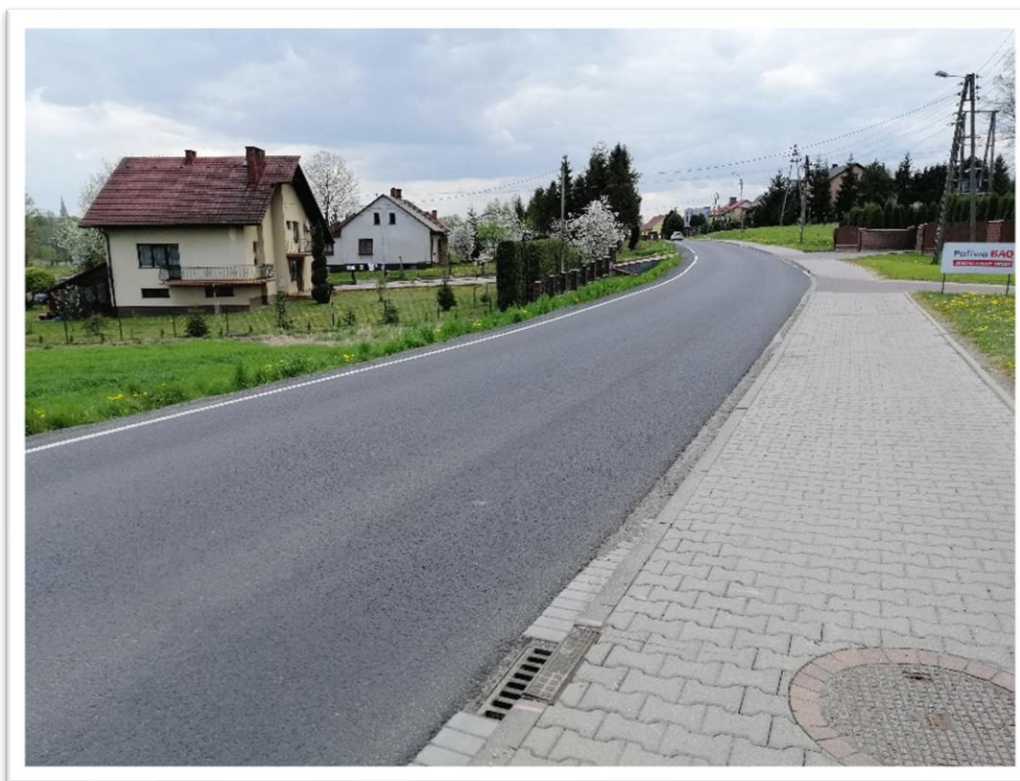
Droga po remoncie (ul. Główna, Osiek)
