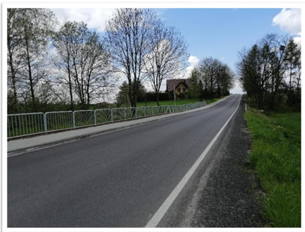
Droga po remoncie (ul. Wadowicka, Głębowice)
