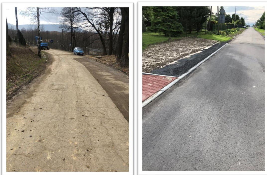
Droga przed i po remoncie (ul. Stara Droga, Bulowice)
