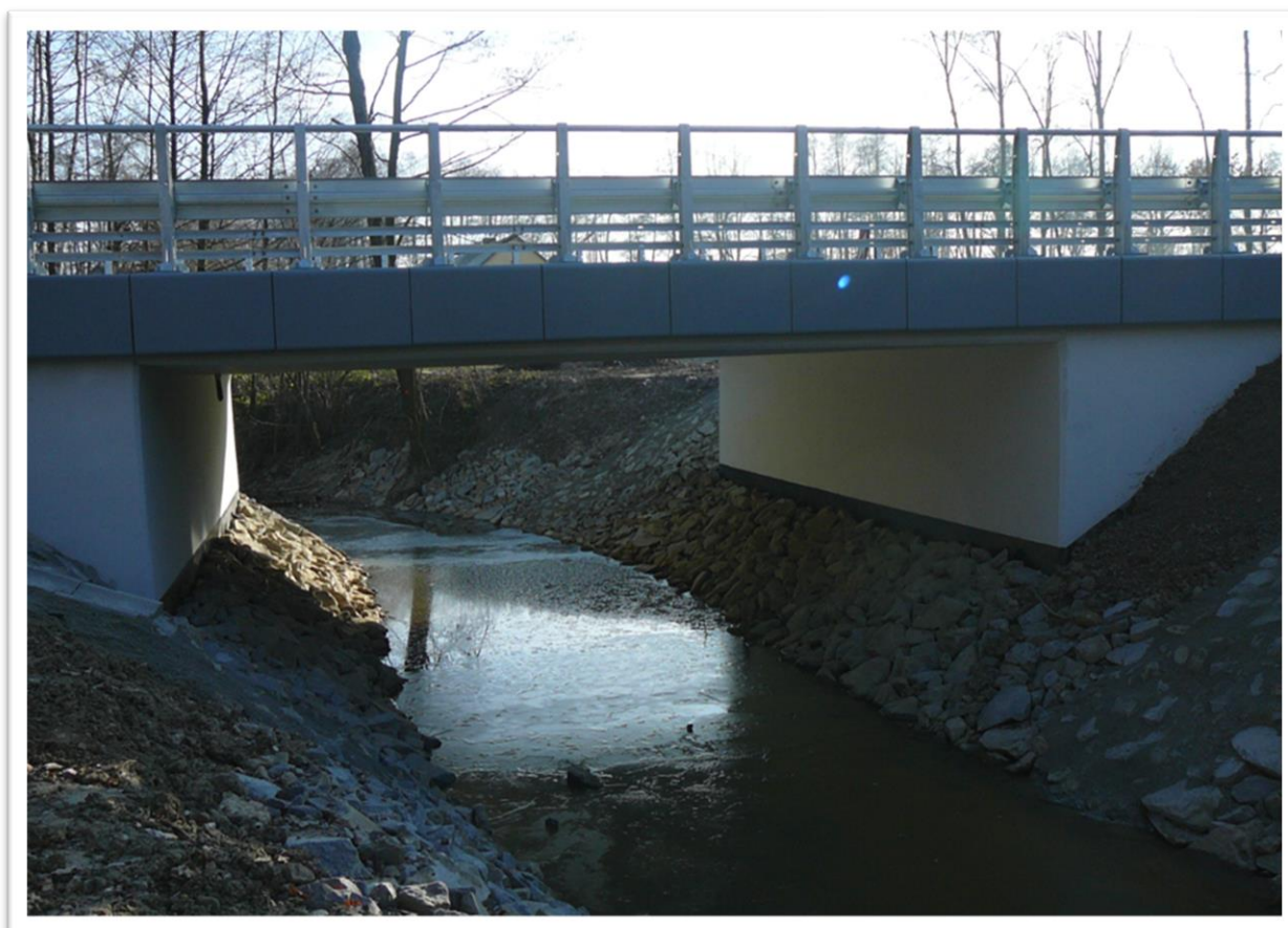
Widok mostu po remoncie (ul. Karpacka, Witkowice)
