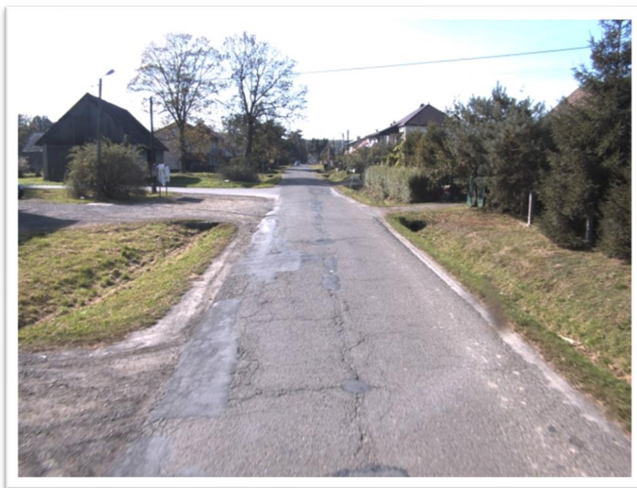
Droga przed remontem (ul. Główna, Graboszyce)
