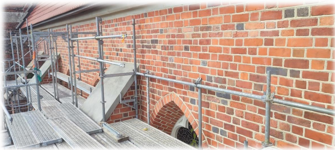
Prace konserwatorskie - elewacja południowa Sanktuarium MBWW
