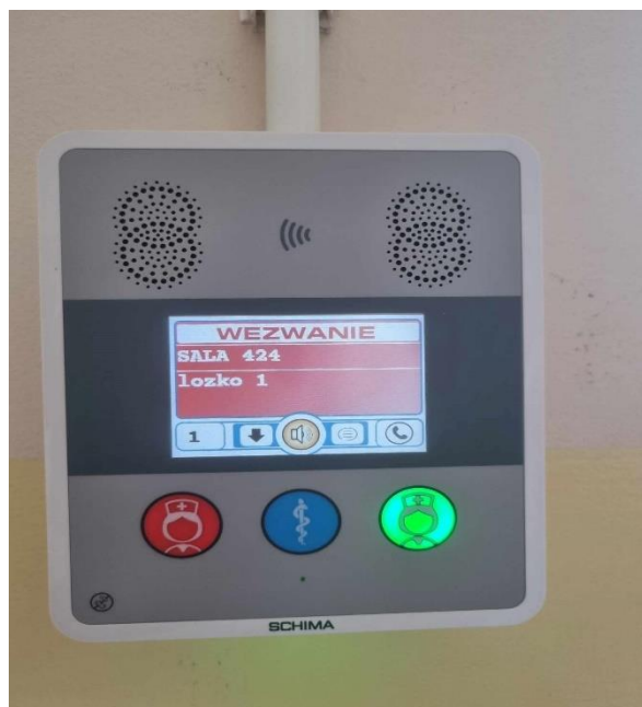
System przyzywowy Oddział Chirurgii Ogólnej oraz Oddział Neurologiczny
