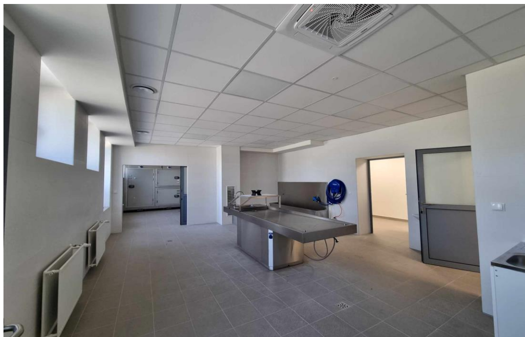
Wyremontowana sala sekcyjna w budynku prosektorium
