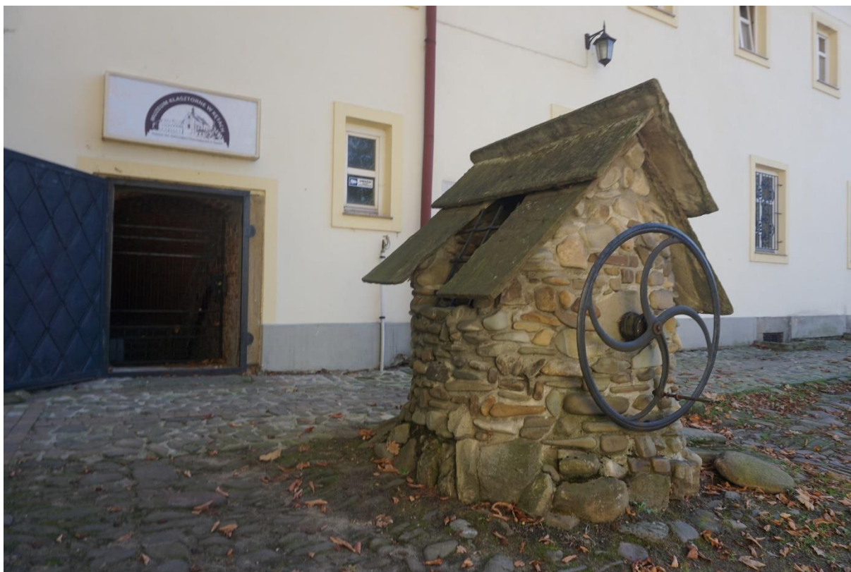
Studnia gospodarcza na terenie zespołu klasztornego. Powstała na początku XVIII w., wykonana z otoczaków, odrestaurowana na początku XXI w.
