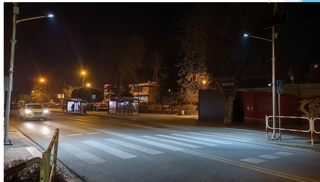
ul. Śniadeckiego w Oświęcimiu (DP 1888K)
