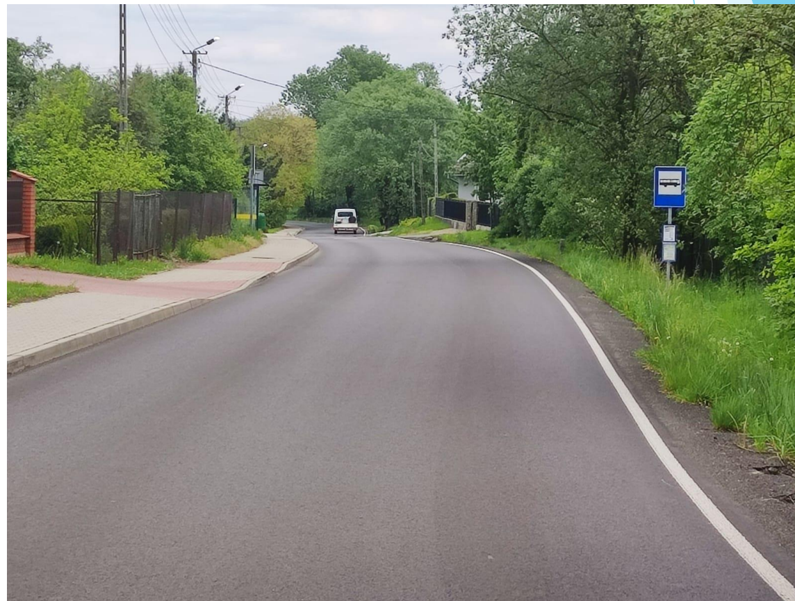
ul. Kęckie Góry Północne (DP 1846K)
