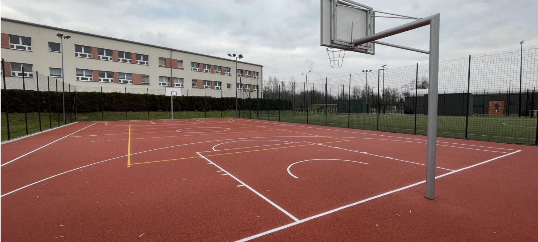
Modernizacja boiska do koszykówki przy Powiatowym Zespole nr 2 SOMSiT w Oświęcimiu
