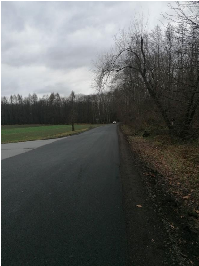
ul. Bielańska w Jawiszowicach (DP 1874K)
