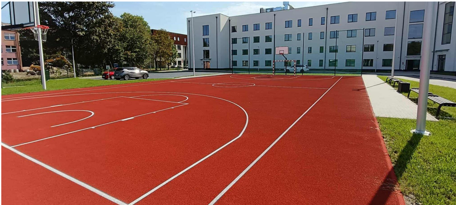
Budowa siedziby SOSW w Oświęcimiu - etap III
