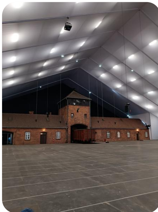
Hala namiotowa nad budynkiem B-1
